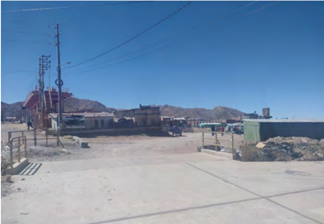
Fig. 1: Vista del área habilitada como muelle en Desaguadero (Perú).
